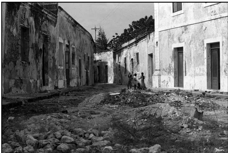
Fotografias 27 e 28: “Este sector (Norte), apresenta hoje uma grande degradação pela não conservação das suas construções e infra-estruturas.” (Citação da página 58).
