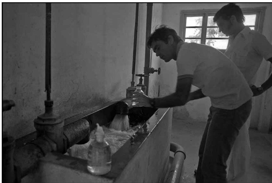
Fotografia 40: "A água filtrada não é tratada com cloro, pois o doseador está avariado há vários anos." (Citação da página 85)
